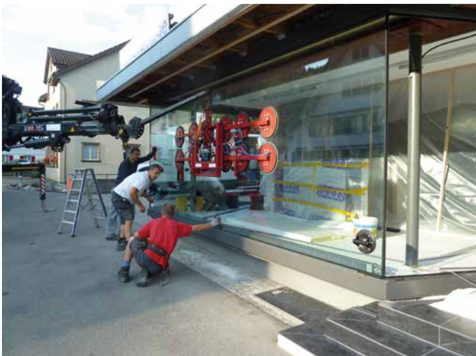
Knifflige Angelegenheit: Der Einbau der Schaufensterscheibe am neuen Standort in Fischingen.
