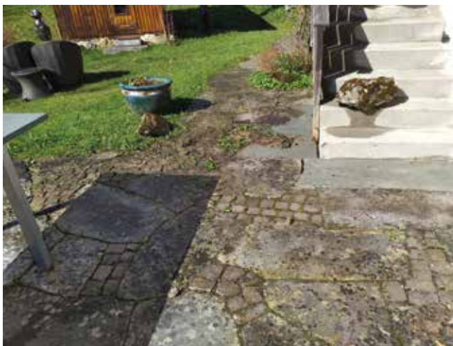
Naturstein Sitzplatz vor der Reinigung: Unkraut, Moos und unschöne Flecken haften an den Steinplatten und den Verbundsteinen; die Fugen sind marode. Die Feuchtigkeit dringt tief ein und es bilden sich Pilze.
