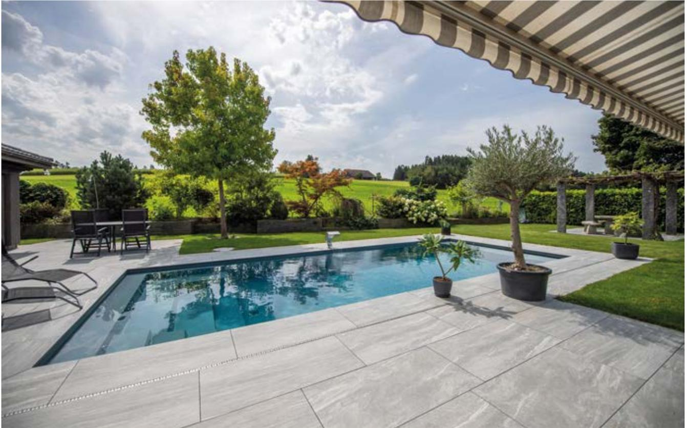
So bleibt man gerne zu Hause. Die Poolanlage sowie der Sitzplatz wurden mit dicken Feinsteinzeugplatten, die auf Splittbeton geklebt wurden, ausgestattet.
